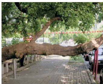
早期架設的紅漆鐵架(右)耐不住樹幹成長的壓力，適時加上不鏽鋼架(左)，全程保護的佳例。
