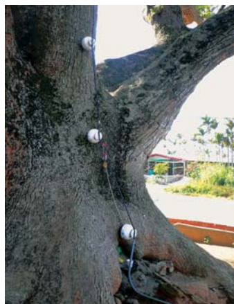
直接裝置在樹體的避雷針，引線應有 避雷針頭一定要突出於樹冠最高點。 絕緣體。
