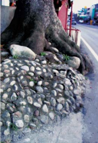
又是水泥又是石頭，壓得喘不過氣的根部。
