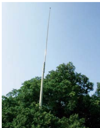
直接裝置在樹體的避雷針，引線應有 避雷針頭一定要突出於樹冠最高點。 絕緣體。
