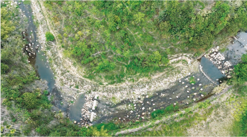
農村發展及水土保持署於南投縣國姓鄉種瓜坑溪推動河川復育工程，拆除溪流右岸護岸，並降低其坡度，使洪水可再度溢淹於原本的洪氾平原，減少下游洪峰，可說是國內少見「還地於河」之案例。該復育工程亦移除河道內之大部分固床工，未移除之一座固床工則打開數個數個缺口，改善水流與生物之縱向連結。(洪諭瑩 攝)
