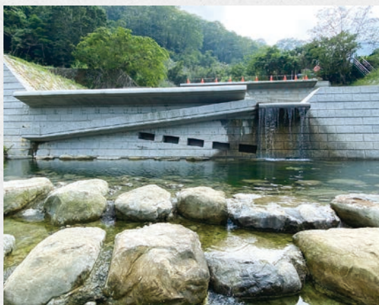
納入魚道的野溪整治工程常被視為「生態友善」的作法，然而魚道實為河川生態系遭破壞後的「補償性」措施，也不能算是自然解方。(廖桂賢 攝)
