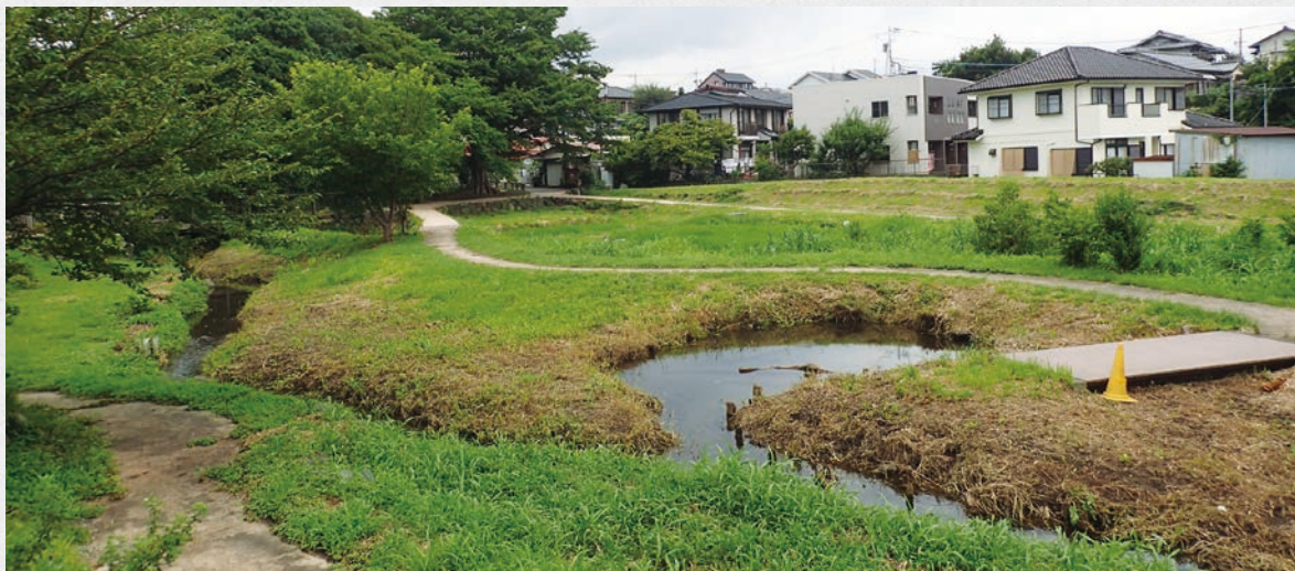
日本靜岡縣三島市的境川，流經綠地之河段原計畫以三面光傳統工法進行防洪整治，並將河道擴大為原本的5倍寬，以擴大通洪斷面。然而傳統工程手段會劣化溪流生態且大幅縮減綠地面積。非營利組織「Groundwork三島」居中協調，改變了設計，將此處營造成濕地，兼具滯洪功能，達成溪流生態、水患治理、綠地保育三贏。(廖桂賢 攝)
