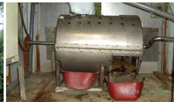
玉山主峰線第一代生態廁所收集桶全貌，須靠手輪帶動鏈條將排泄物與木屑混合。(齊泰榮 攝)
